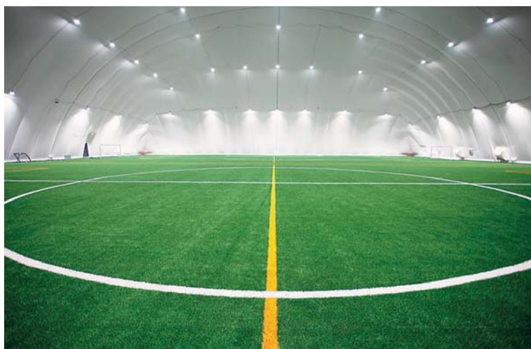
Marco Football Center to pierwszy w Europie obiekt trwale łączący pneumatyczną kopułę z murowanym budynkiem zaplecza sportowo-biurowo-socjalnego
